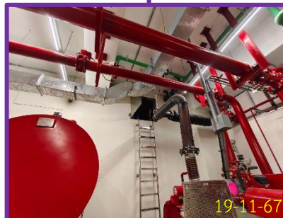
ถังเก็บน้ำชั้นใต้ดิน 1 และ 2 มีปริมาตรเก็บกักรวม 2,268 ลบ.ม.
