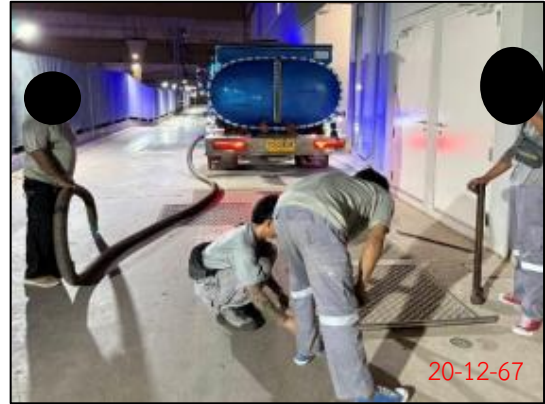
การจัดเก็บตะกอนส่วนเกินของระบบบำบัดน้ำเสีย
